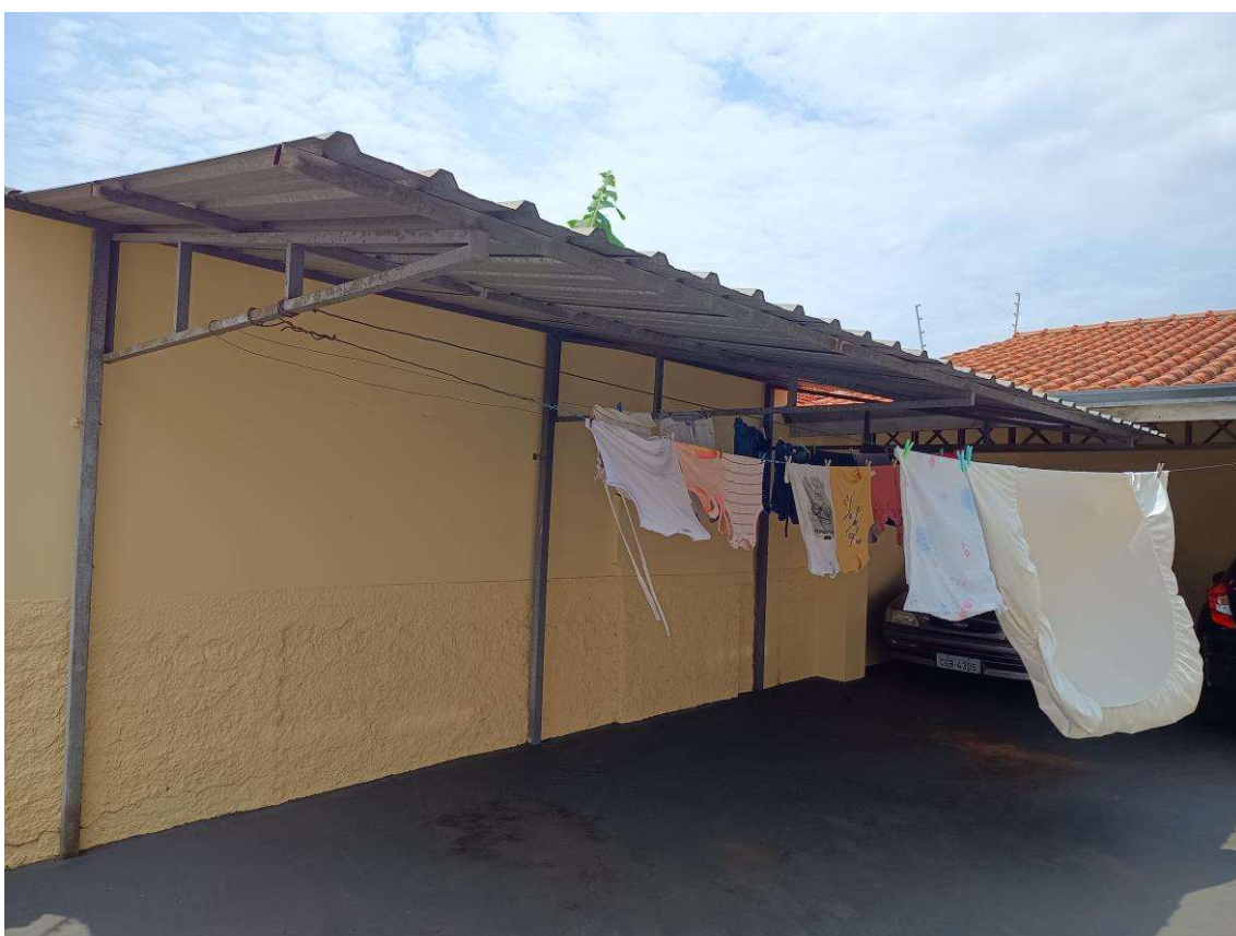
02- Vista corredor de acesso, cobertura metálica.
