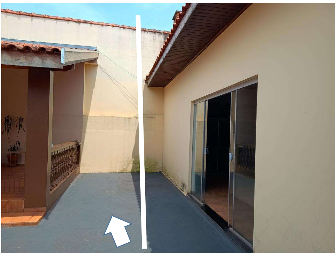
04- Área avaliada, localizada no fundo do terreno.
