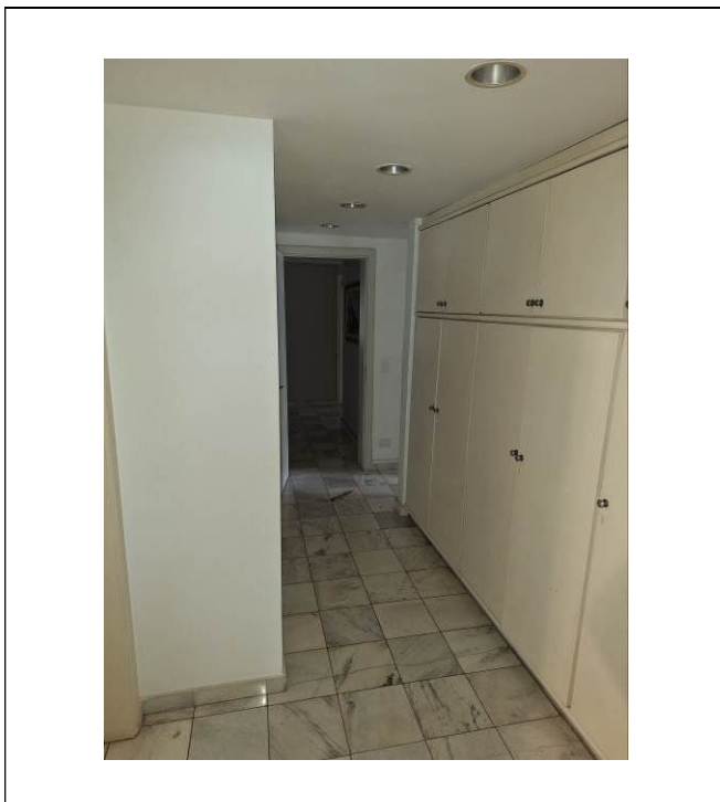
Foto 29: Hall de distribuição
