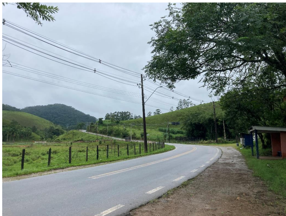
Figura 03: Vista da Estrada Pedro David, na altura do imóvel vistoriado
