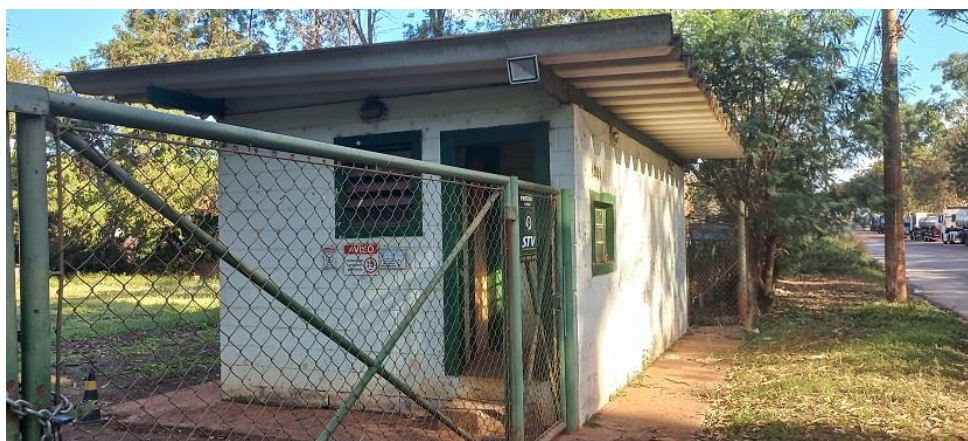
Detalhe da Guarita:
