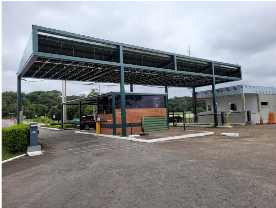
Fotografia 03 – Aspecto da portaria de acesso ao Condomínio Residencial Patrimônio do Carmo, junto ao Km 54 da Rodovia Bunjiro Nakao.
